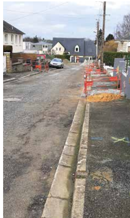
Rénovation des réseaux Rue Penot
